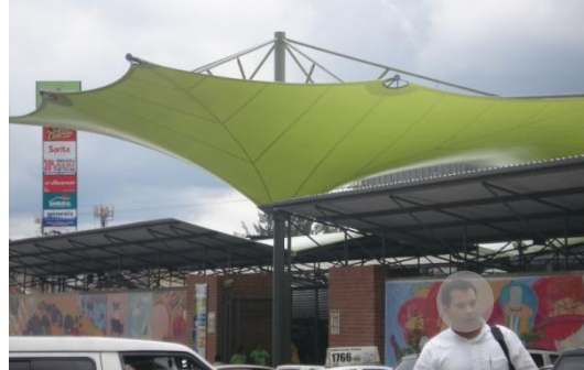
Detalle sobre paso a desnivel el MATE
