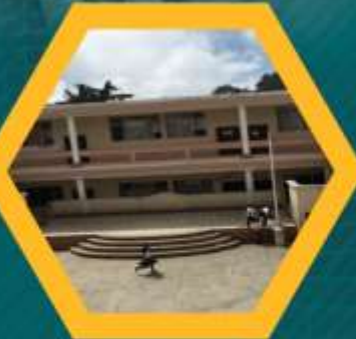
Construcción Escuela Primaria Fase II, Aldea Ciénega Grande, municipio de San José Pinula
