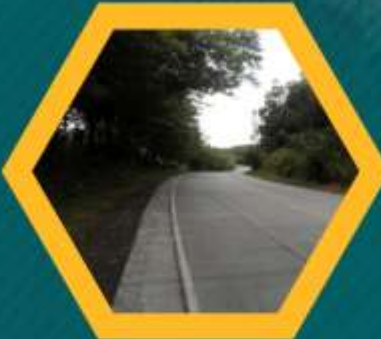
Mejoramiento y pavimentación de la Ruta Nacional 7E, Tramo 4; El Estor-Puente Sumache, Izabal
