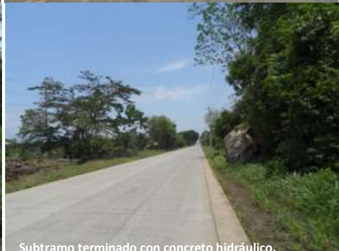
Subtramo terminado con concreto hidráulico.
