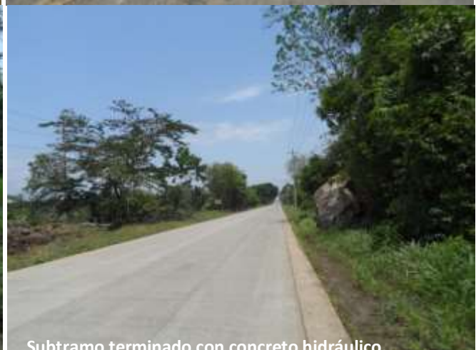
Subtramo terminado con concreto hidráulico.
