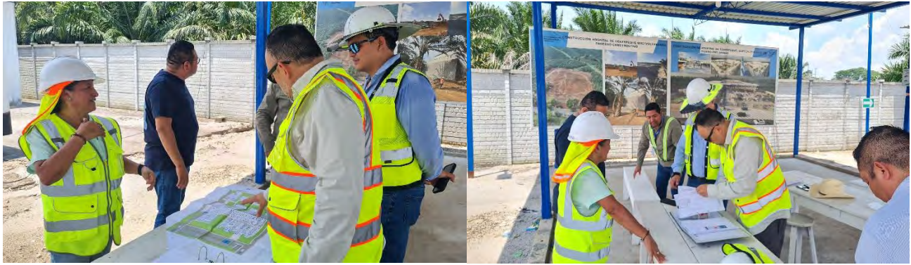
Fuente: Fotos tomadas por el equipo de aseguramiento CoST.
