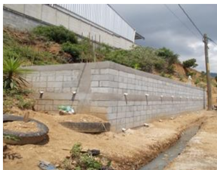
MURO DE CONTENCIÓN
